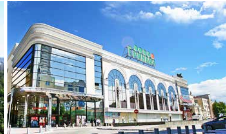
ТРЦ Гринвич, г. Екатеринбург Установленные системы: ОПС, АДУ, АПТ
