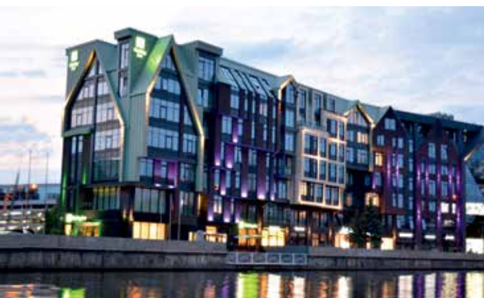
гостиница «Holiday Inn», г. Калининград Установленные системы: ПС, АДУ, СОУЭ
