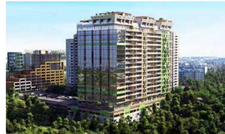
ЖК «Harmony Residence», г. Баку Установленные системы: ПС, АДУ
