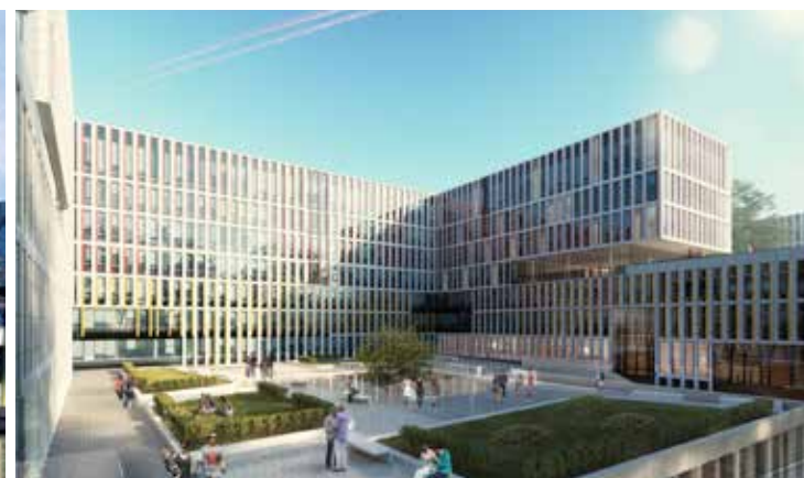
медицинский комплекс в Коммунарке, г. Москва Установленные системы: ОПС, АДУ
