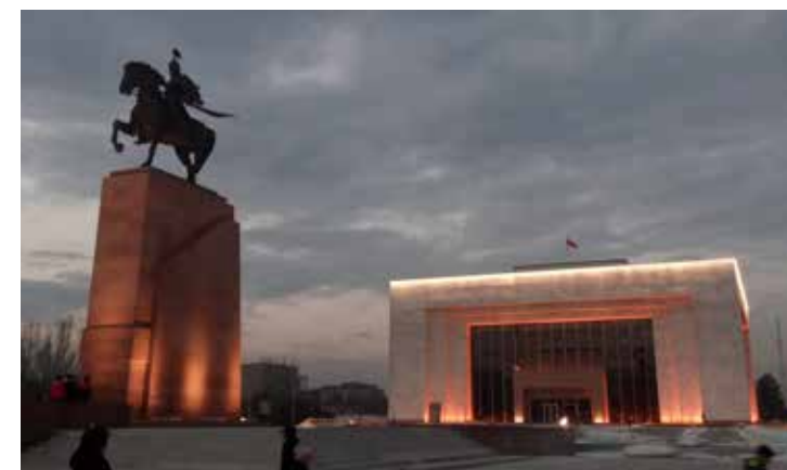
Кыргызский государственный исторический музей Установленные системы: ПС, ОС, СКУД, СОУЭ, ПТ, ДУ
